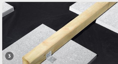
Unterkonstruktion hochkant und mittig auf die Steinplatten legen und an mindestens drei Punkten mit Metallwinkeln befestigen. Je nach Holzart und Stärke der Terrassendielen sollte der Abstand der Unterkonstruktion zwischen 20 und max. 50 cm liegen.
