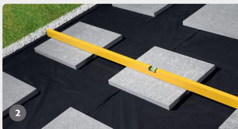
Jetzt Stein- oder Gehwegplatten verlegen. Der Abstand der Platten muss entsprechend dem zukünftigen Abstand der Unterkonstruktion gewählt werden. Bitte kontrollieren Sie nochmals das Gefälle.
