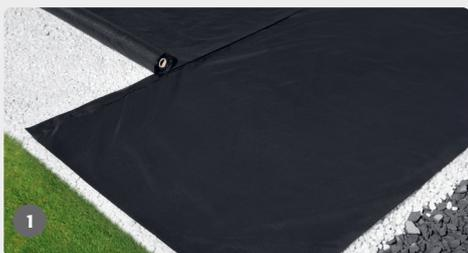
Als ersten Schritt legen Sie eine ebene Fläche an. Anschließend wird eine grobe Schotterschicht (20-40 cm) und eine anschließende Kiesschicht (5 cm) auf der Fläche verdichtet. Bitte beachten Sie, dass die Fläche ein Gefälle von ca. 1-2 % haben muss. Es wird empfohlen, zusätzlich ein Unkrautvlies als Schutz zu verlegen.
