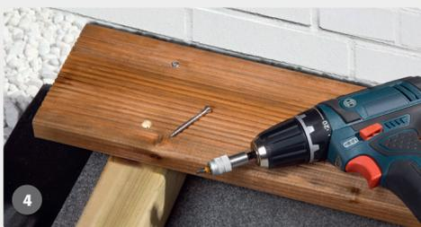
Terrassendielen im rechten Winkel zur Unterkonstruktion ausrichten. Bitte achten Sie auf ausreichend Abstand zu festen Bauteilen wie Wänden. Es sind zwei Verschraubungen je Brettbreite pro Kreuzpunkt mit der Unterkonstruktion erforderlich. Wir empfehlen Ihnen, vor dem Schrauben mit einem Bohrer mit Senker vorzubohren.
