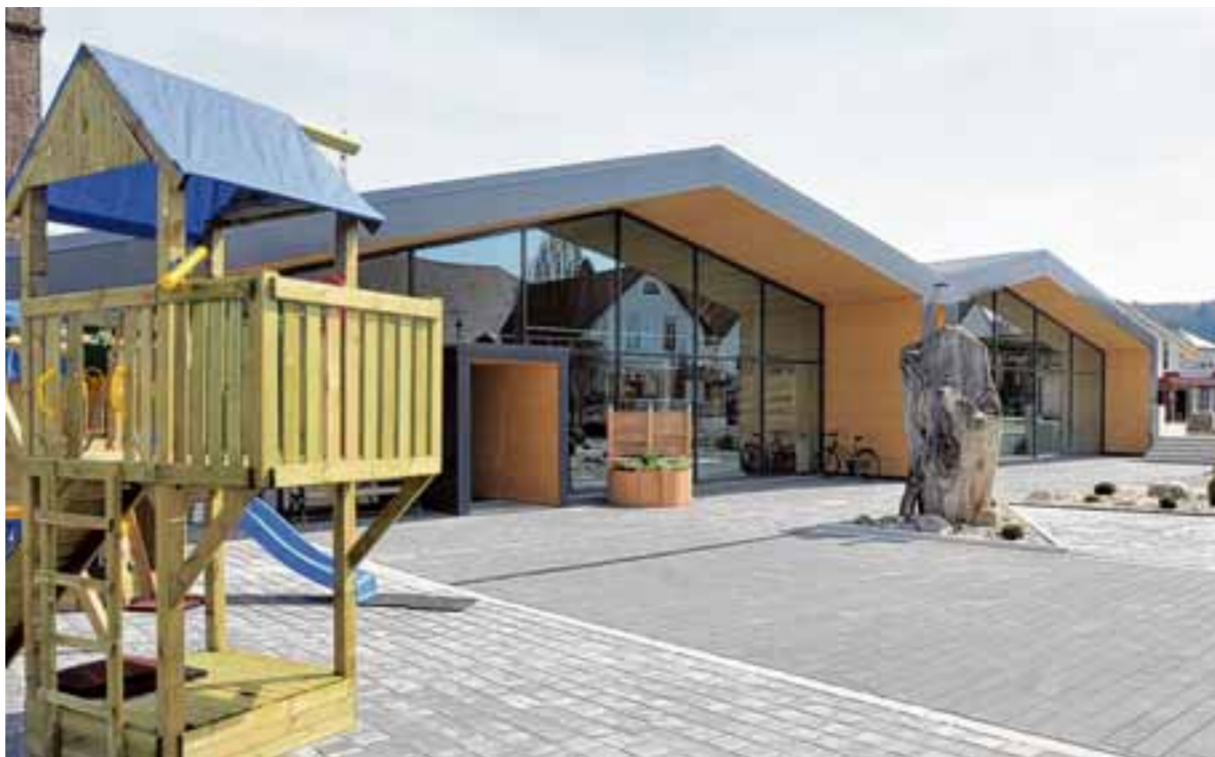
1000 Quadratmeter Ausstellungsfläche baute 2013 der Holzfachmarkt Jochum in Zusmarshausen an bestehende Gebäude an. Dafür wurde das Unternehmen jetzt mit dem Parkett Star ausgezeichnet. Foto: Andreas Lode
